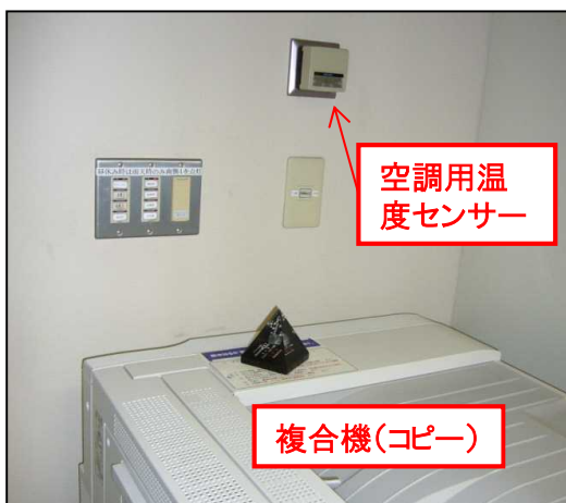
写真1 空調温度センサー付近の複合機
